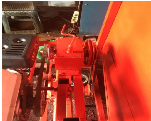
Pemasangan couple pengeras v-belt
