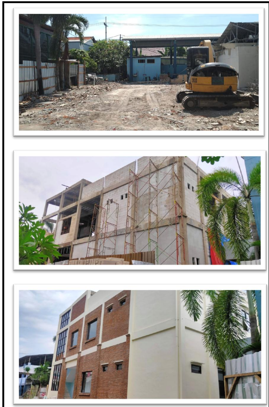
Gambar 3.3. Dokumentasi Foto Pembangunan Gedung Laundry RSUD Sidoarjo
