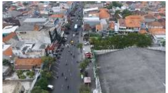
Gambar C.44 STA 0 + 700 (Dokumentasi Drone)
