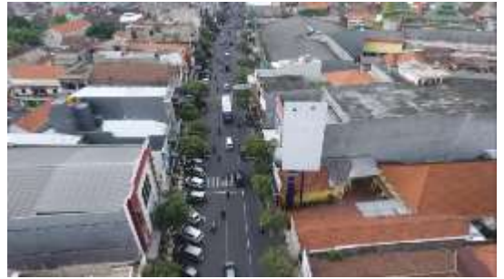
Gambar C.42 STA 0 + 500 (Dokumentasi Drone)
