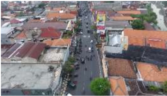
Gambar C.41 STA 0 + 400 (Dokumentasi Drone)
