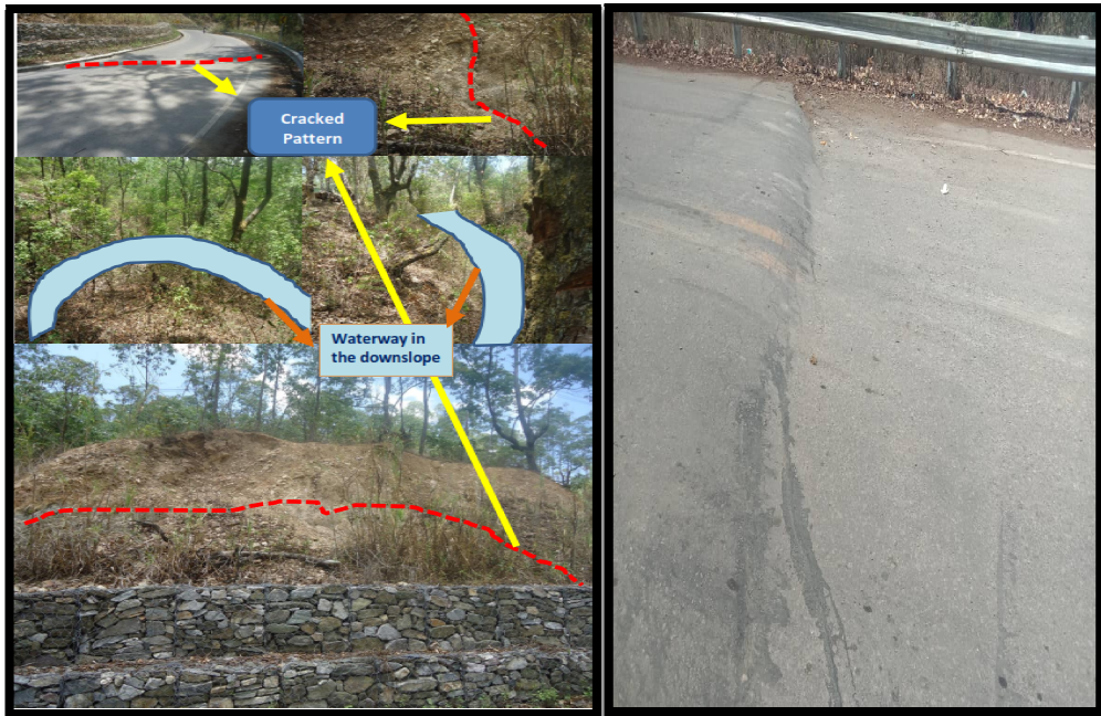
Gambar 3.5 Kondisi saat ini di Sta. 39 + 447
