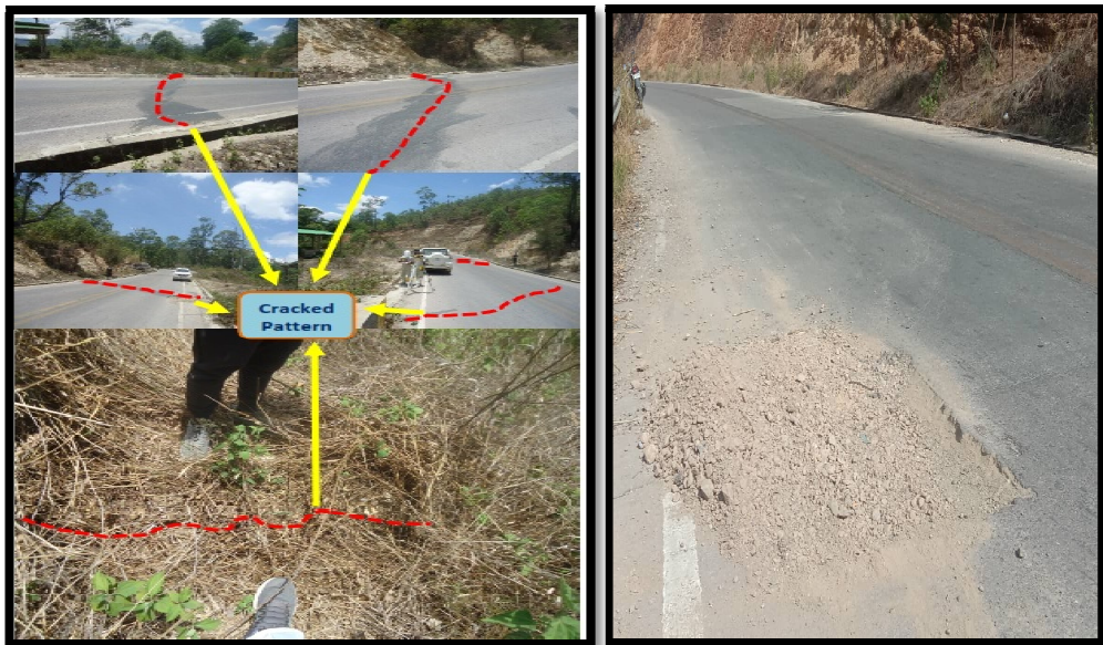
Gambar 3.5 Kondisi saat ini di Sta. 39 + 625
