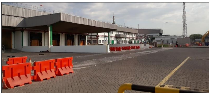
Lampiran 4. Area loading dock dan parkir truk
