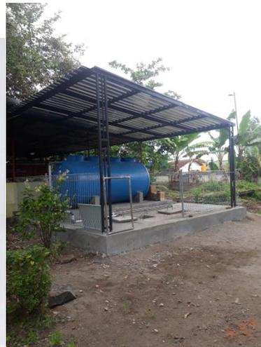
Gambar proses penyaringan air limbah yang ditarik dari bak control pertama dengan hasil akhir pembuangan air bersih. Contoh tanki IPAL dengan kapasitas 5000 liter.
