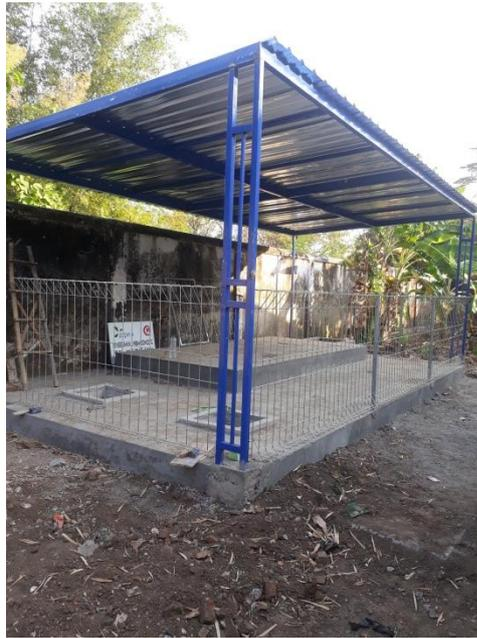
Contoh hasil proses perencanaan pada gambar sebelumnya. Fungsi dari bak control diatas untuk proses awal penyaringan atau filterisasi air limbah sebelum di proses dalam tanki IPAL, disini terdapat 2 bak control ukuran besar dan 1 kecil, sedangkan yang ukuran kecil berfungsi untuk pembuangan akhir setelah proses filterisasi.
