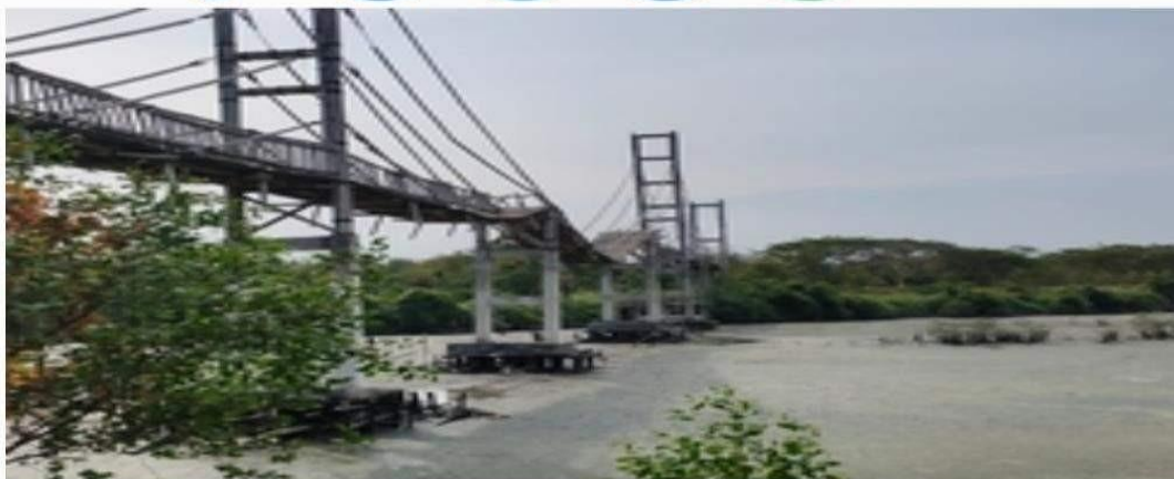
Proyek Jembatan Mangrove yang tak kunjung dirampungkan akibat pandemi covid-19. [Foto : zaenul arifin]
