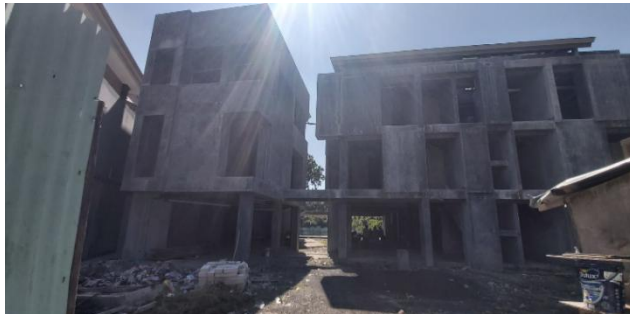
Gambar 5.1 Proyek Greenwood House (Sumber : P.T Catur Eka Manunggal Jaya)
