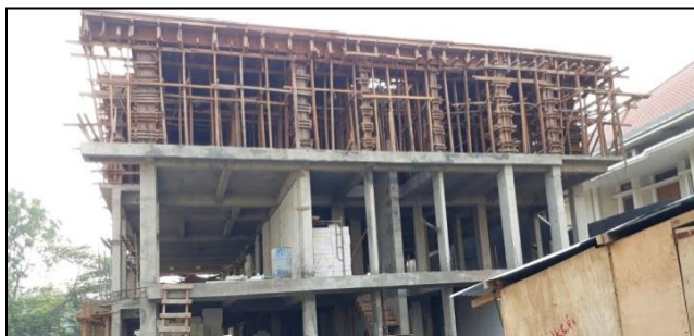
Gambar 5.3 Pekerjaan Struktur (Sumber : P.T Catur Eka Manunggal Jaya)
