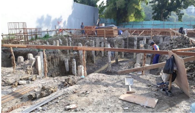
Gambar 5.4 Pekerjaan Pondasi (Sumber : P.T Catur Eka Manunggal Jaya)
