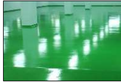
Gambar 18. Lantai Epoxy Sumber : Google
