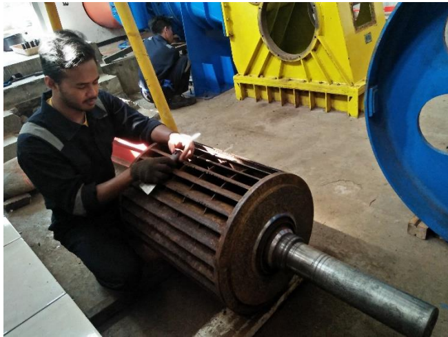
Pembongkaran Runner Pada Saat Overhaul
