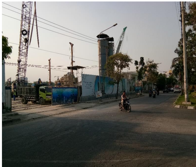
Gambar 2. Lokasi depan proyek
