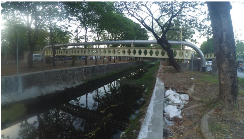
Saluran Eksisting Kali Margomulyo STA 1+0.00
