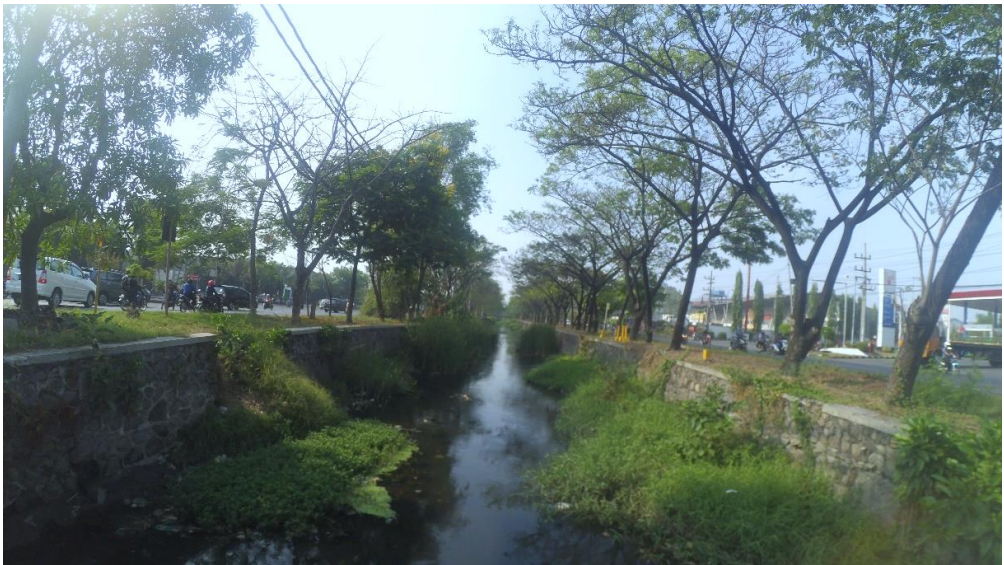
Saluran Eksisting Kali Margomulyo STA 4+1.500
