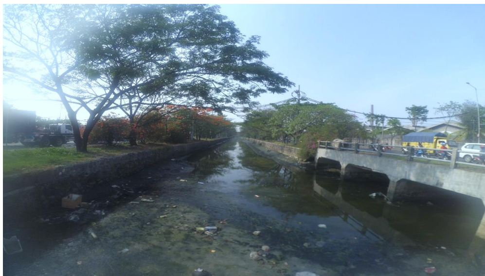
Saluran Eksisting Kali Margomulyo STA 5+3.000
