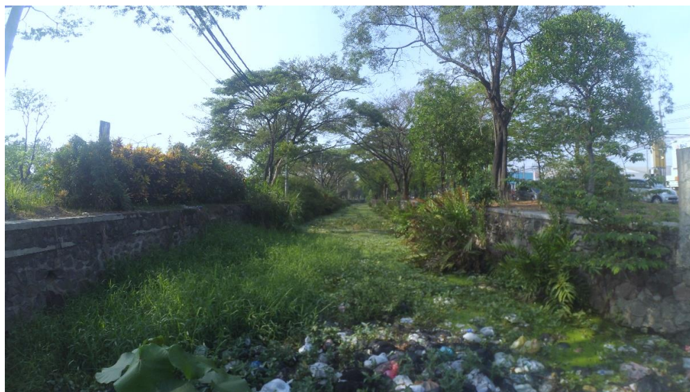
Saluran Eksisting Kali Margomulyo STA 2+0.500
