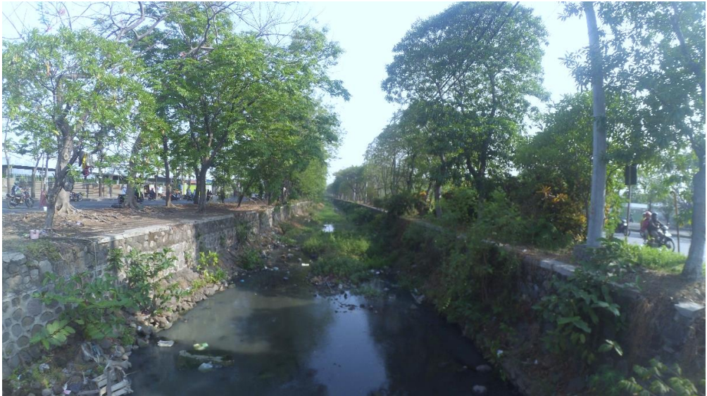
Saluran Eksisting Kali Margomulyo STA 3+1.000
