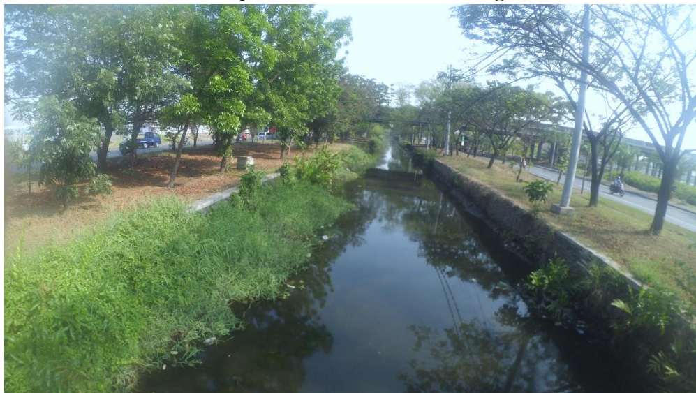
Saluran Eksisting Kali Margomulyo STA 5+2.000
