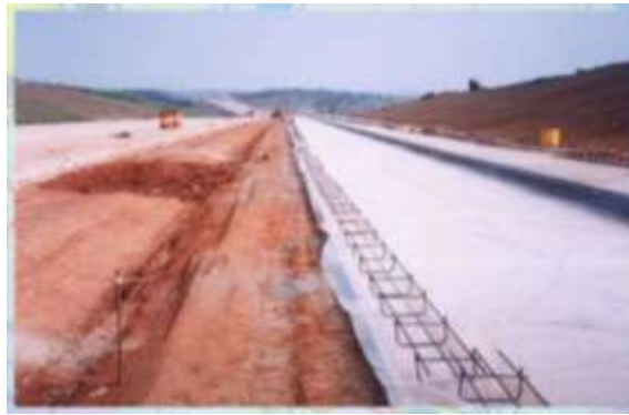
Gambar 2.4 Struktur lapis bond breaker
