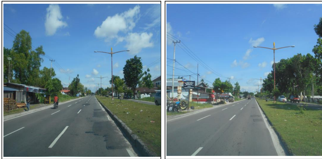
Gambar 4.5. Kondisi jalan setelah pelaksanaan kontrak
