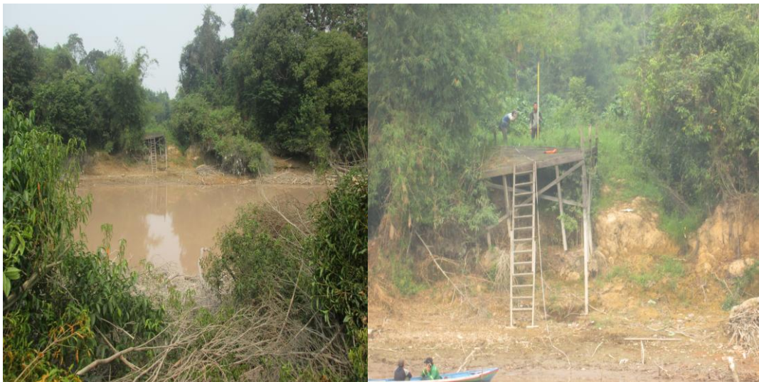
Gambar 1.1 Kondisi Eksisting Jembatan Sei Kalanaman Kabupaten Katingan
