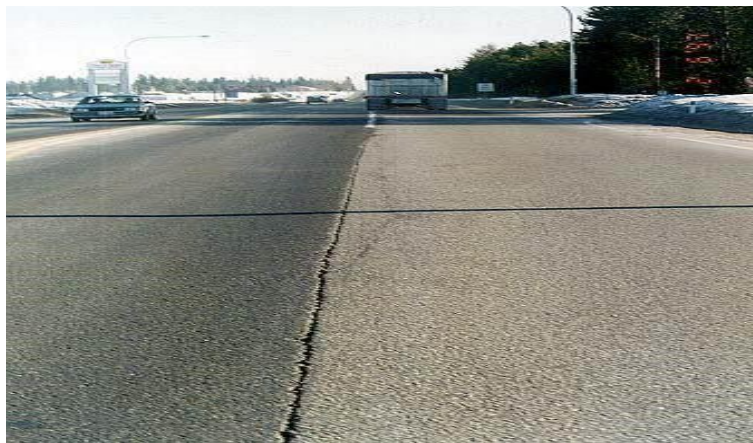
Gambar 2.8. : Retak Sambungan
