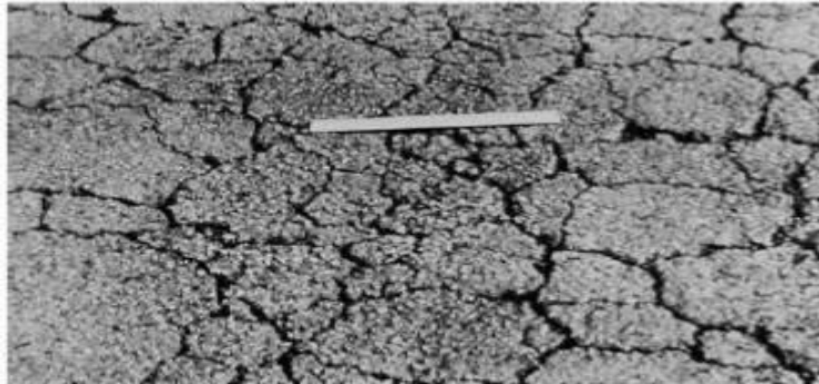
Gambar 2.3. : Retak Blok
