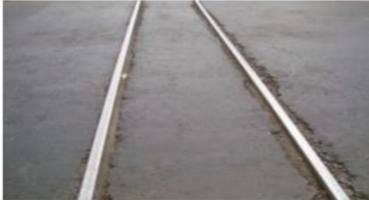
Gambar 2.14. : Rusak Perpotongan Rel
