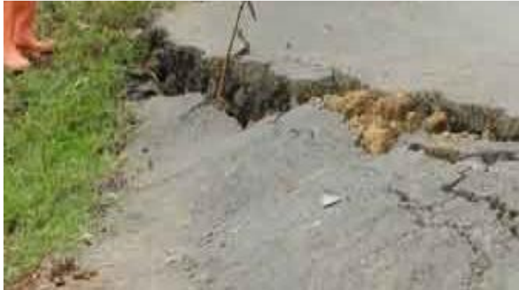
Gambar 2.9. : Pinggiran Jalan Turun
