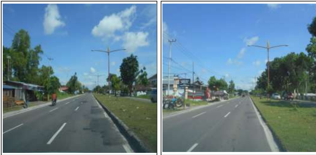
Gambar 4.5. Kondisi jalan setelah pelaksanaan kontrak
