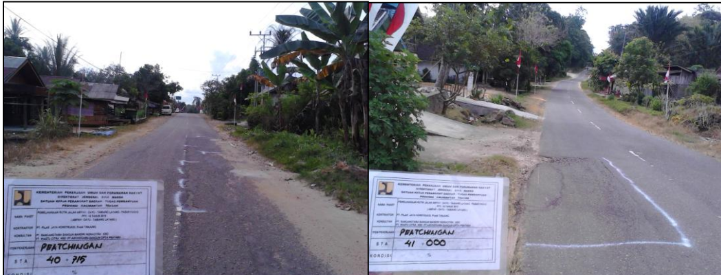
Gambar 1.2 Kerusakan (Retak Memanjang dan Bergelombang)
