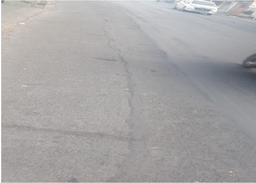
Dokumentasi Foto kerusakan pada retak memanjang pada STA/KM 0+024
