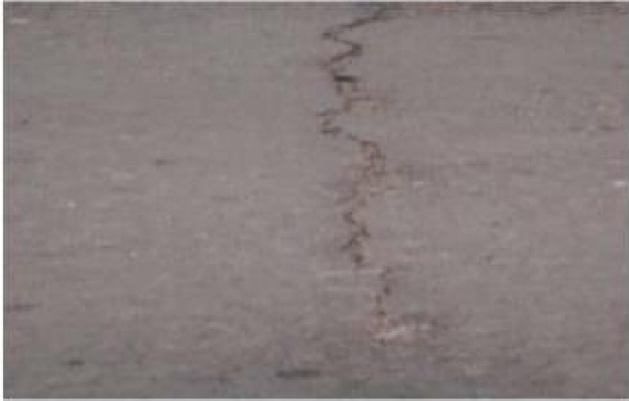
Gambar 2.21 Pinggiran Jalan Turun Vertikal Sumber : Bina Marga (1983)
