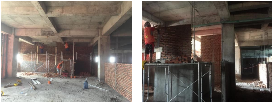
Gambar 4.1 Pemasangan Bata
