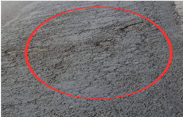
Gambar 4.6 retak halus hasil survey
