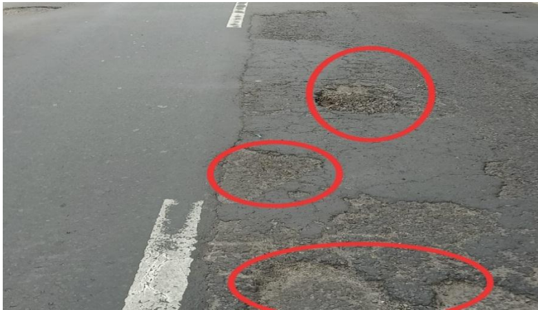
Gambar 4.8 lubang berat hasil survey
