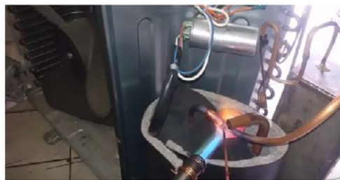
Gambar 6. Proses pengelasan sambungan
