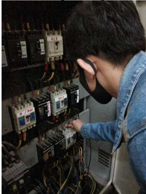
Foto Pemasangan Filter pada MDP
