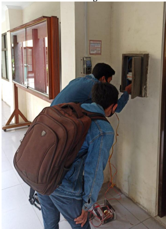
Foto Pemasangan Filter
