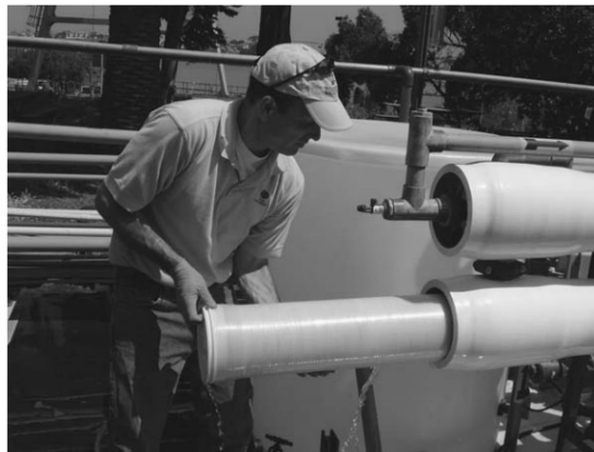
Gambar 2.11. Gambar Proses Membongkar Elemen Membran Reverse Osmosis Dari Bejana Bertekanan.
