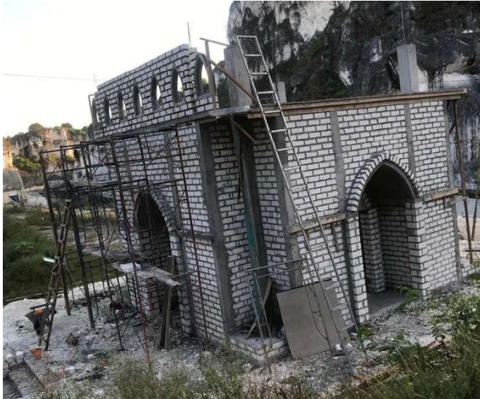
Sarana prasarana mushollah yang masih tahap pembangunan. Gresik, 16 Juni 2020.
