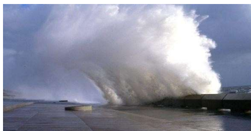
Gambar 2. overtopping yang terjadi pada breakwater
