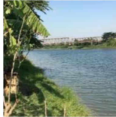
Gambar 2. Jembatan Gama Sumber : Peneliti
