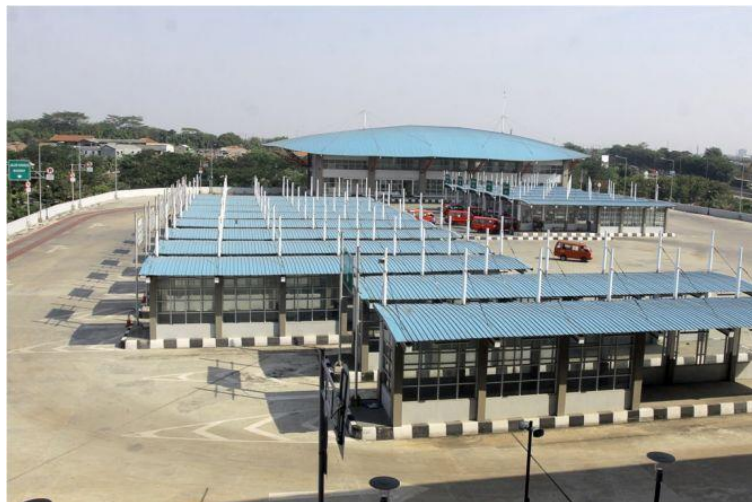
Gambar 2.6 Peron Terminal Pulo Gebang Sumber : mediatataruang.com
