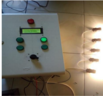
Gambar 20. Kontrol Switch Keadaan PLN ON
