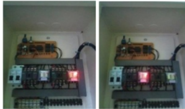
Gambar 18. Kerja Sistem Kontrol Transfer Switch
