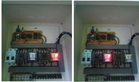
Gambar 18. Kerja Sistem Kontrol Transfer Switch
