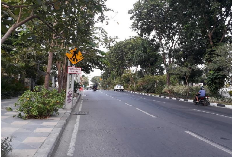
Gambar E.1. Kondisi segmen jalan dari arah Mayjen Sungkono ke arah HR. Muhammad
