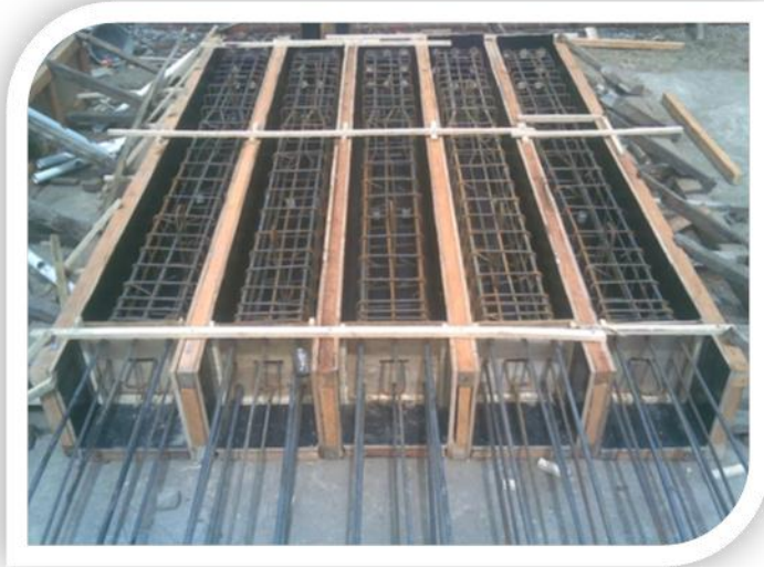
1. Moulding Kolom
