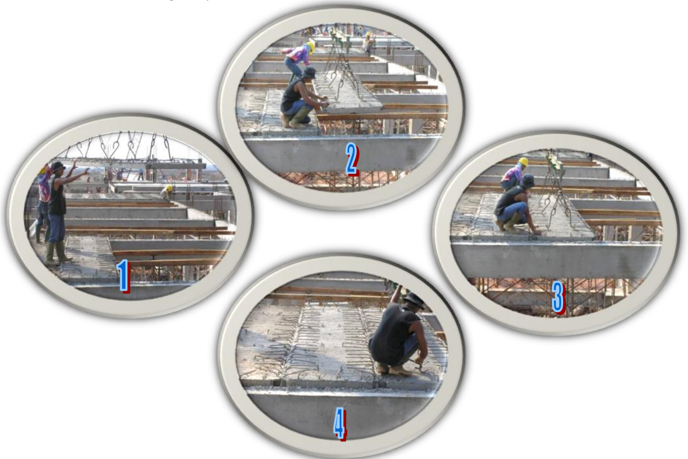
Urutan Kerja Install Slab
