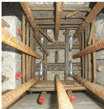
Joint Balok Kolom yang Akan Digrouting
