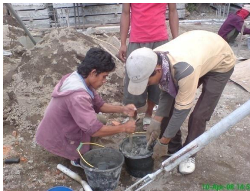
Proses Pencampuran Bahan – Bahan untuk Grouting Joint Balok Kolom
