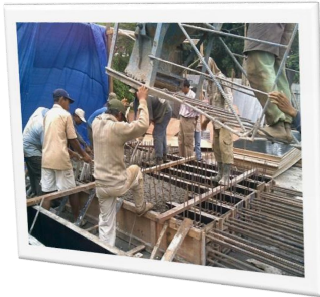
Pengecoran Elemen Precast
