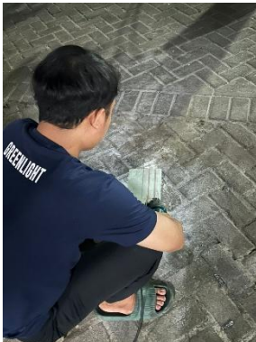
Pengolesan resin dan hardener pada komposit
