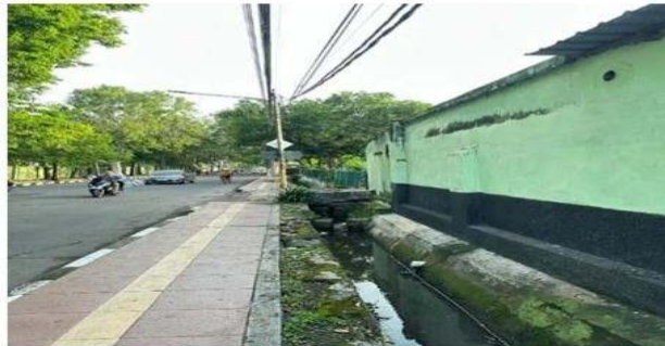
Gambar 2 : Kondisi Existing Saluran Air di Jl. Adityawarman
