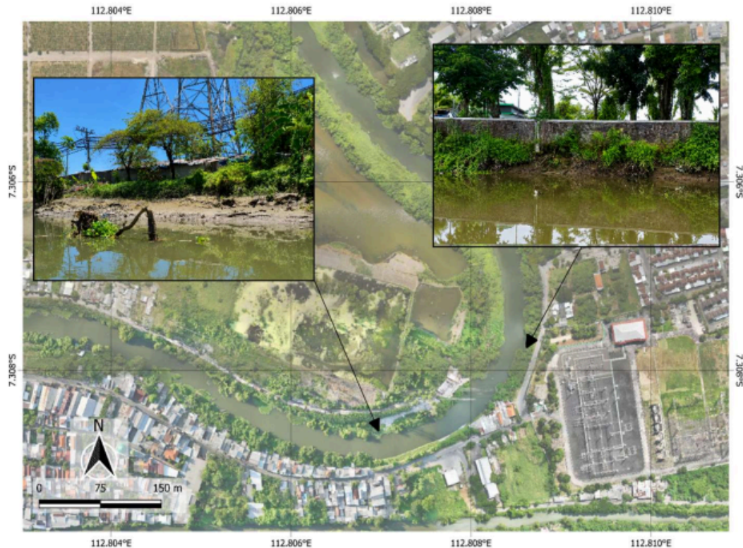
Gambar 3.6 Pata Kondisi Sisi Luar dan Sisi Dalam Tikungan (Sumber : Data Olahan Peneliti, 2026)
