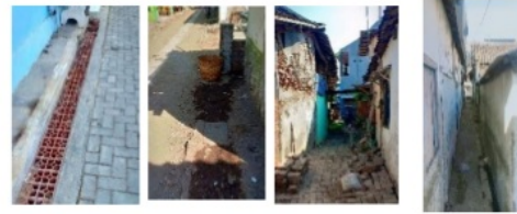
Gambar 3. Kondisi prasarana dan utilitas kampung logam kelurahan mayangan, Kota pasuruan, Jawa timur (Sumber : Survey Lapangan)
