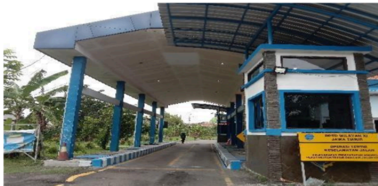
Gambar 3. 2 Jembatan Timbang Trosobo
