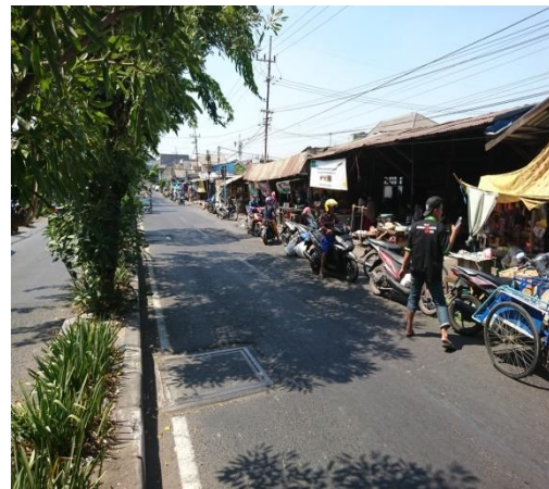
Gambar Kondisi Hambatan Samping di Jalan Menur
