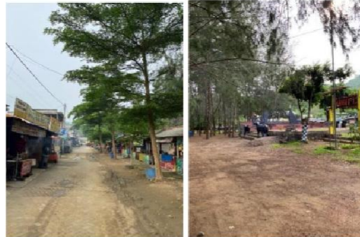
Gambar 1.7 Kondisi Jalan Pantai Gemah
