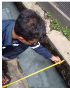
Gambar 3. pengukuran saluran eksisting
