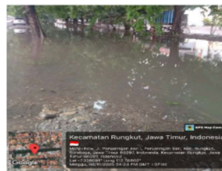
Gambar 3. Kondisi Saluran Primer Saat Banjir
