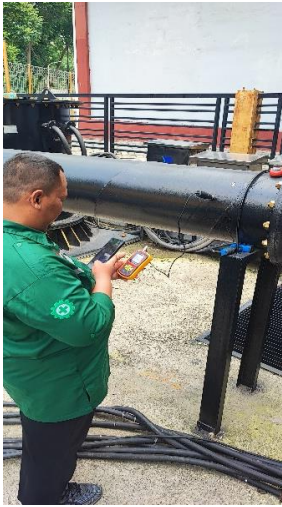
Gambar 5.1 Pengukuran getaran pompa
