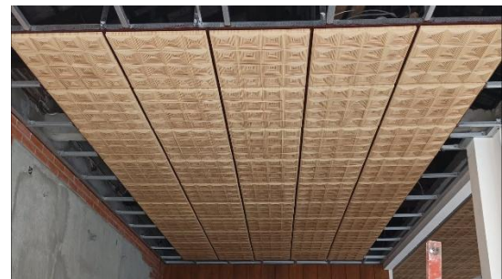
Gambar 11. Penerapan Material Anyaman pada Ceiling
