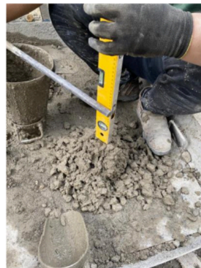
Gambar 15 Pengujian Slump Beton
