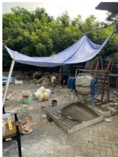
Gambar 14 Kegiatan Pengecoran Beton
