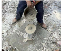
Gambar 2 Penuangan adukan beton
