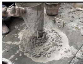
Gambar 3 Penjatuhan adukan beton alir
