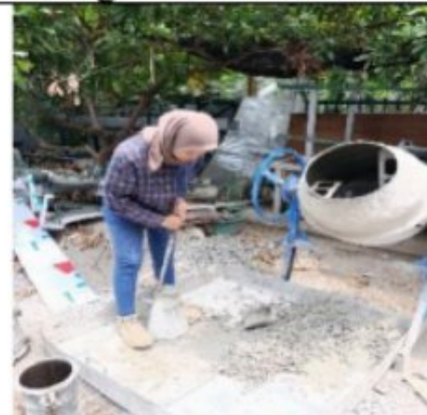
4. Melakukan pengujian slump beton
