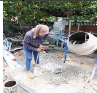
4. Melakukan pengujian slump beton
