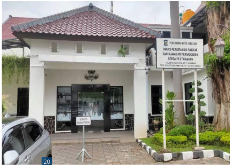
Gambar 4.1 Kantor Dinas Perumahan Rakyat dan Kawasan Permukiman serta Pertanahan
