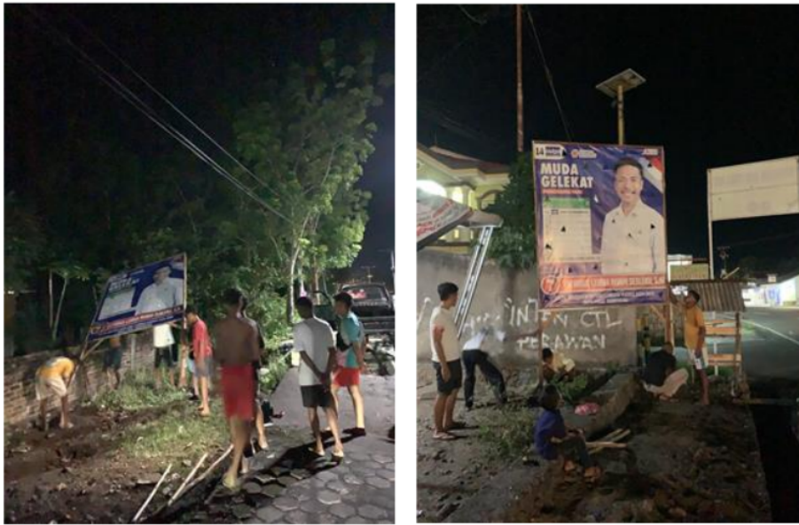
Gambar 4.2.3.1 Proses Pemasangan Baliho Elfridus Leirua Rivani Sableku, S. H
